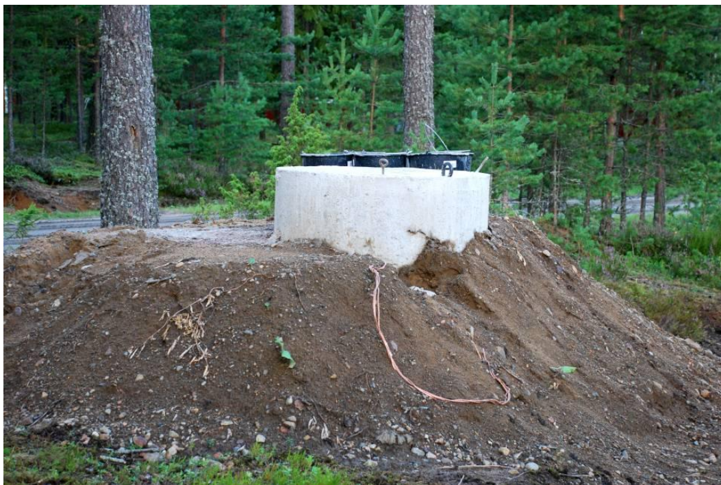
OH2RA/OG2A 49 m maston jalka. Malli tukeva, kiinteän osan paino 2500 kg. Masto nousee 10.9.2008 alkaen: 4 x JP2000. 73 Markku.
